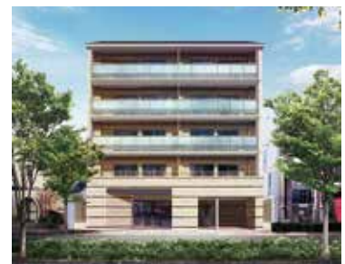
パラドール 京都下鴨 2022年3月竣工(25戸)
