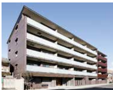
パラドール 太秦天神川・華苑 2020年1月竣工(45戸)
