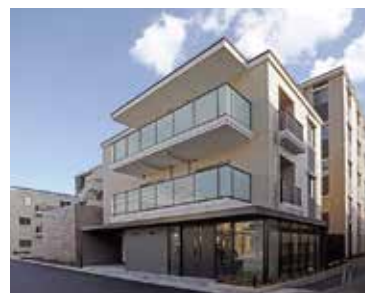
パラドール 四条梅津 ザ・ファースト 2020年12月竣工(35戸)
