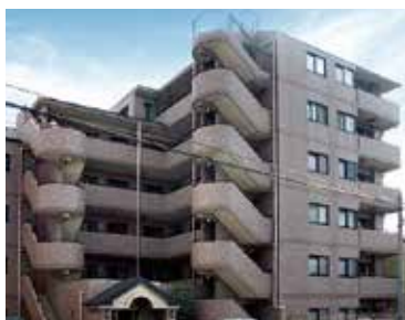
パラドール 太秦 1995年6月竣工(27戸)
