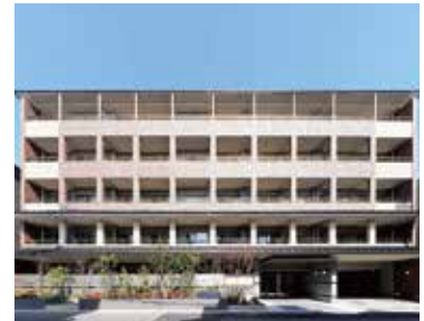
パラドール 烏丸鞍馬口・凛苑 2018年1月竣工(34戸)
