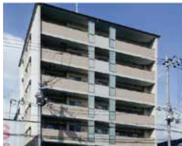
パラドール 四条葛野大路 シア・スタ 2013年1月竣工(36戸)
